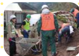
支援活動(土砂の撤去作業)
